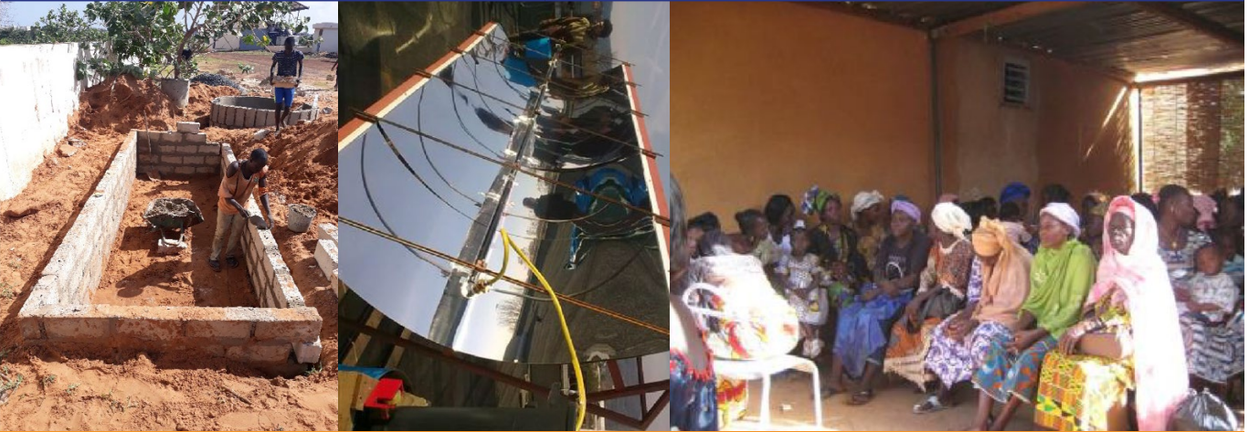
Zone humide construite pour le traitement des eaux usées à Dakar (à gauche) Concentrateur à Auge Parabolique (PTC) pour la désinfection de l'eau potable au Cameroun (centre) Femmes du Centre Médical Saint Camille à Ouagadougou (Burkina Faso) pour un programme de recherche sur la transmission mère-enfant du VIH (à droite)
