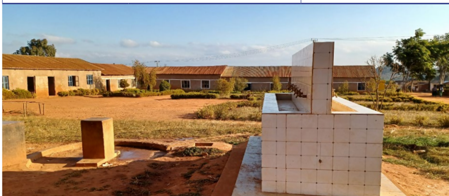
Approvisionnement en eau potable et assainissement à l'école - Iringa
